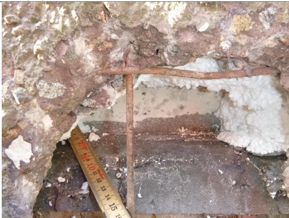
Foto 4: (P1090409.JPG) Understopning af bagvæg er intakt. Der er pap over sokkel.
