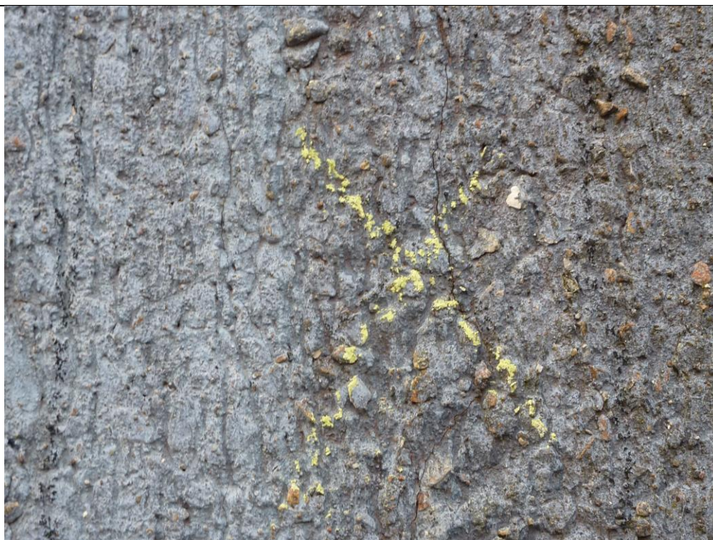
Foto 18: (P1180623.JPG) Typiske revner i blåt element.
