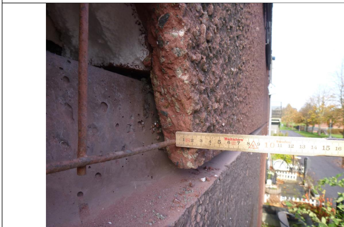
Foto 6: (P1090416.JPG). Elementunderside "tåen" med armering. Her er armering i midten og har dæklag på 20 mm til både for- og bagside.
