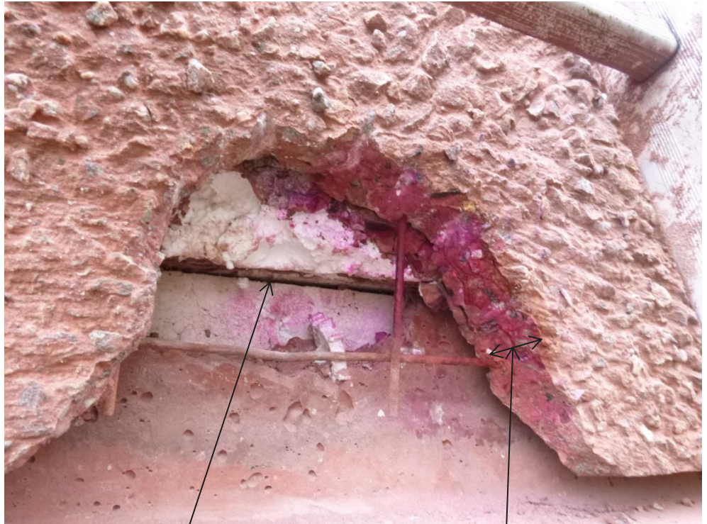
Frihugning i vandret samling mellem to elementer. Isolering ( t = 30 mm) i nederste element ses ført helt op til kant af element. Polystyrol i overstående element støder her helt op til underliggende. Dæklag på armering er ca. 30 mm fra forsiden og ca. 10 mm fra bagsiden. Karbonatiseringszonen er 2-3 mm.
