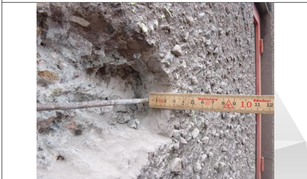
Foto 8: (P1090452.JPG). Dæklag på armering er over 20 mm.
