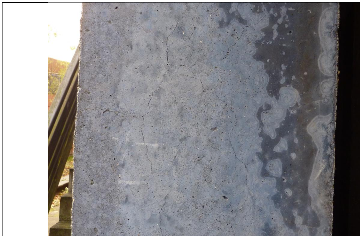
Foto 19: (P1180626.JPG) Underside af portelementbjælke.
