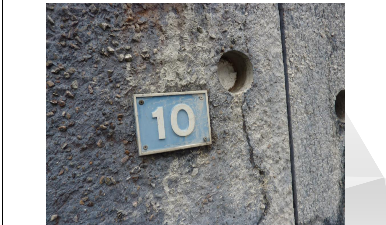
Foto 22: (P1180666.JPG) Borekerne K3 udtaget i revne i blåt facadeelement. Til højre ses borehul for kerne udtaget i portelement.
