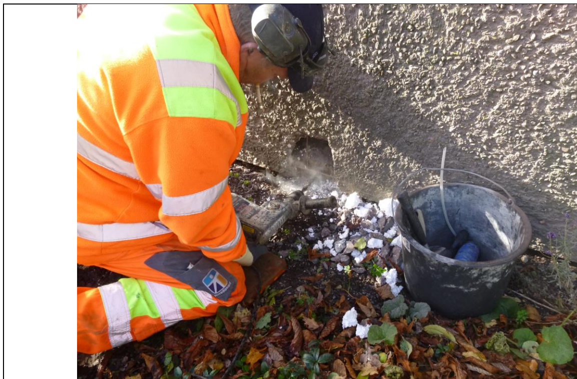
Foto 5: (P1090410.JPG). Boring i sokkel for at bestemme isoleringstykkelse.
