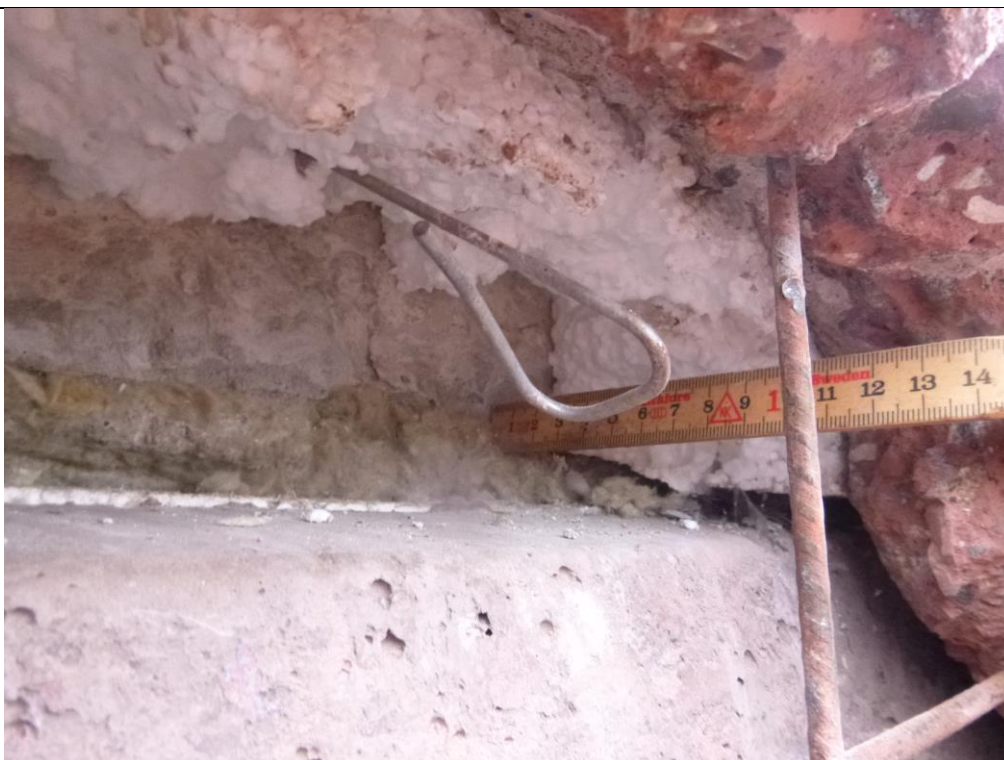
Foto 1: (P1090372.JPG) Frihugning i top af element. Fra forside af element til forside af bagvæg er den projekterende afstand 160 mm. Armering er 5 mm tentorstål.
