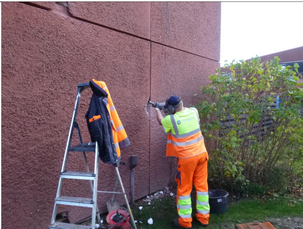
Foto 2: (P1090396.JPG) Boring for at finde tykkelse af isoleringslaget.
