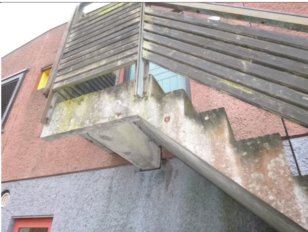
Foto 15: (P1090618.JPG) Her er udtaget kloridprøver fra underside af konsol. Der er afskallet over clamsjern. Rækværk er ret nedbrudt.
