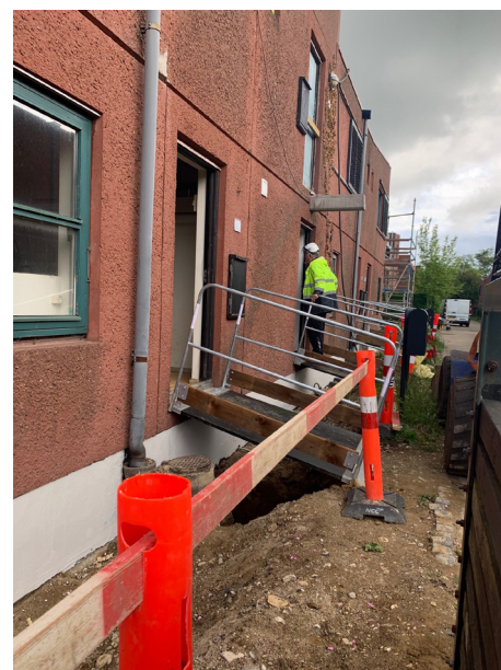
Der etableres rampe hen over opgravningen, så du - selvfølgelig- kan komme ind og ud af din bolig.
