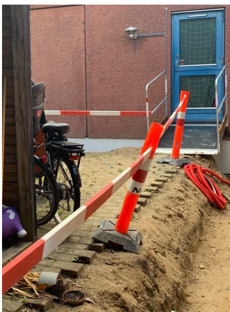
Det vil stort set ikke være muligt at benytte haven under renoveringen.
